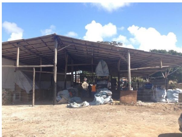
Figura 4-22 – Galpão de Triagem provisório.
